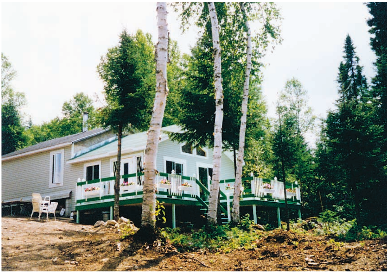
Ce chalet est construit sur un lot loué d'année en année par l'État québécois, en zone de villégiature.
