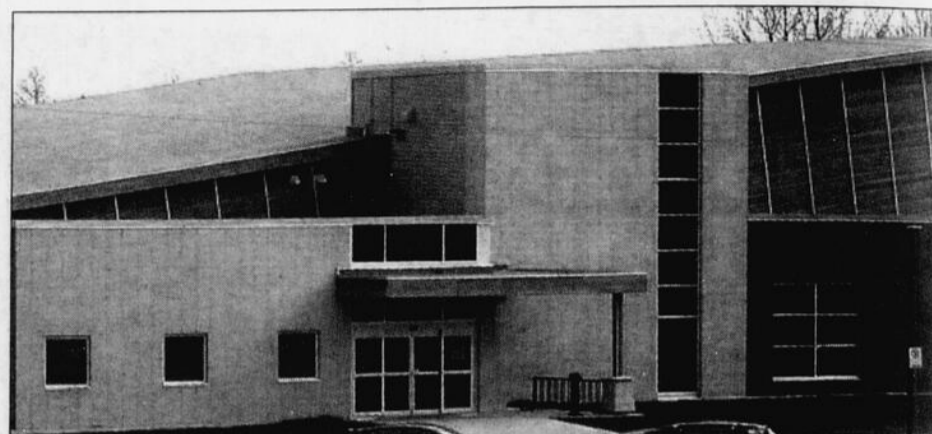
Un système de vidéo surveillance sera aussi installé à la piscine Édouard-Dubord.
