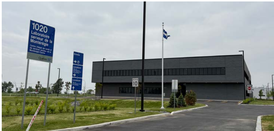
La construction du laboratoire serveur de la Montérégie est terminée. (Photo : Frank Jr Rodi)
