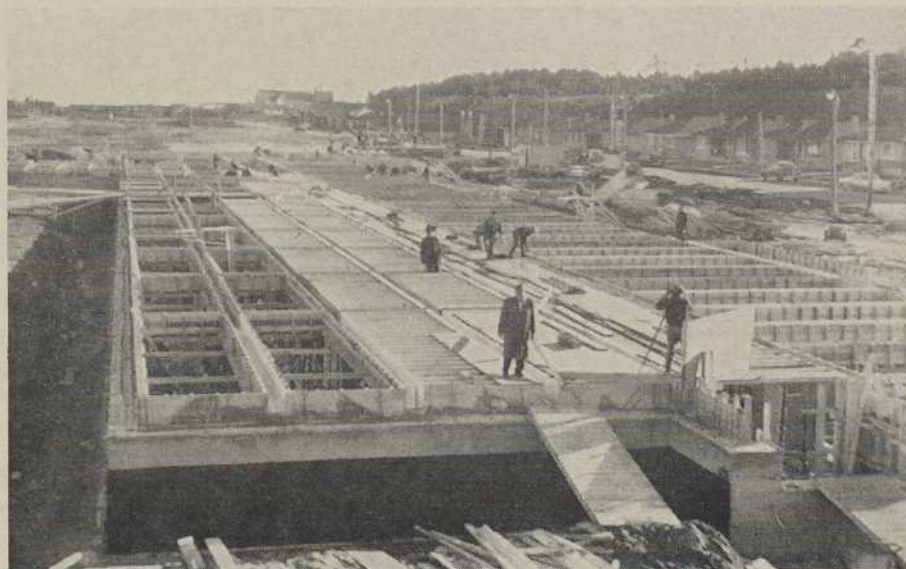
On a ici une idée de l'importance des travaux de construction du nouvel Institut de Technologie de la cité trifluvienne. A la mi-décembre, on avait coulé le béton des fondations. Ce grand rectangle est celui de la partie avant de l'édifice. L'aile des ateliers s'étendra en arrière du corps principal.
