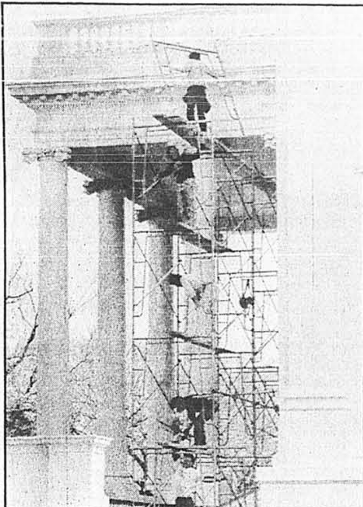
Des ouvriers décapent la Maison-Blanche recouverte d'une trentaine de couches de peinture. PHOTOLASER AP
