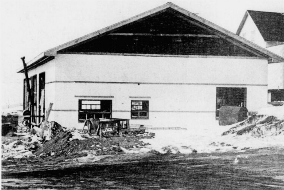
Le garage municipal, en construction.
