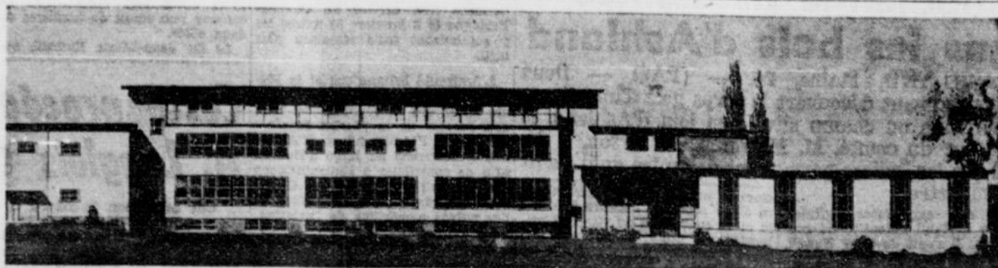
LE NOUVEAU PENSIONNAT INDIEN, EDIFIE A AMOS, EN ABITIBI. — Cette maquette représente le nouveau pensionnat indien d'Amos, présentement en construction sur une ferme de 300 acres. L'édifice très moderne comprendra six salles de classe, une chapelle, de vastes dortoirs et salles de récréation, un petit hôpital, un couvent
