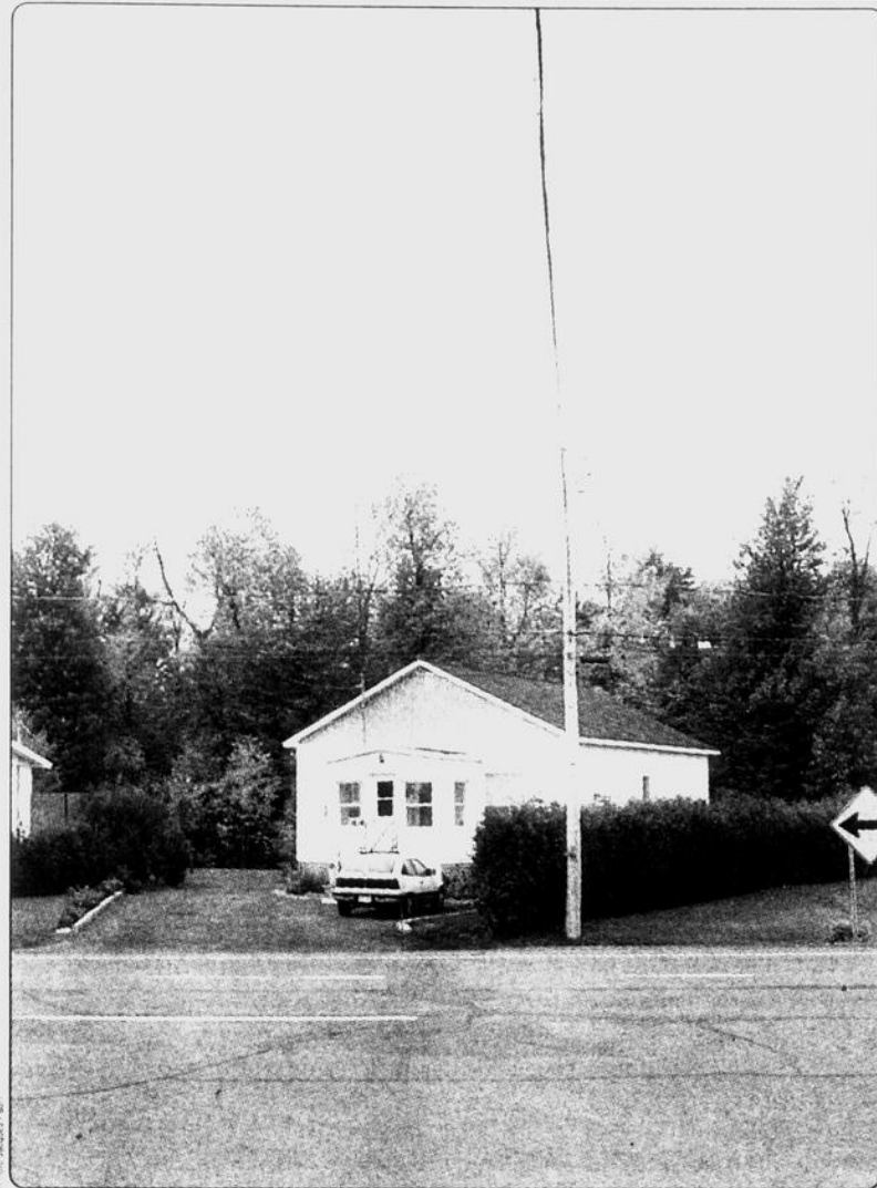
La Ville vient d'acquiescer pour 128 000$ cette propriété (à droite sur la photo) du 182 boulevard Saint-Luc qui sera démolie pour permettre de relier la rue Douglas au boulevard Saint-Luc.
