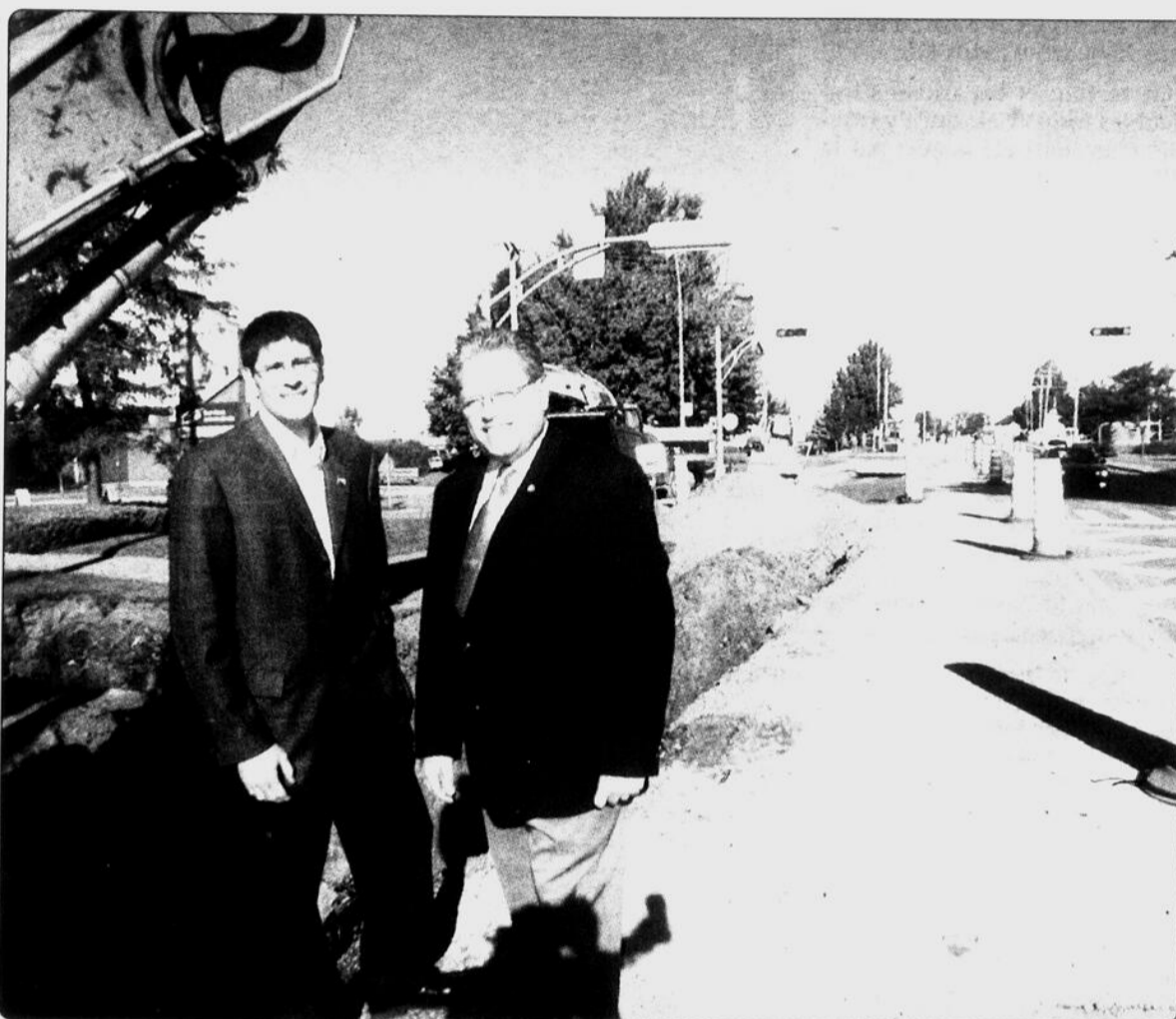
L'ingénieur Benoit Senécal et le conseiller Alain Paradis sur le boulevard Saint-Luc où des travaux majeurs d'infrastructures sont en cours.
