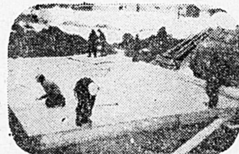
en deux heures, on charpente le plancher sur la fondation déjà érigée par vous
