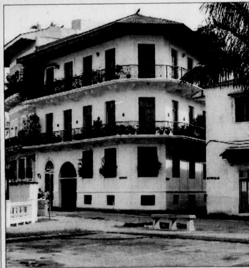
Une des seules maisons restaurées du quartier historique de San Felipe. Cette résidence appartient au chanteur panaméen Ruben Blades.
