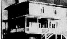
5720 - 175, 2e Rang Ouest, Ste-Odile. Cottage 5 chambres avec bâtiments, terrain de 53 819 pieds carrés. René Lepage 724-9309
