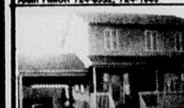
5783 - Rue Siérols. Magnifique résidence, 2 étages, 3 chambres, 2 salles de bains. Alain Fillon 724-6332, 724-1905
