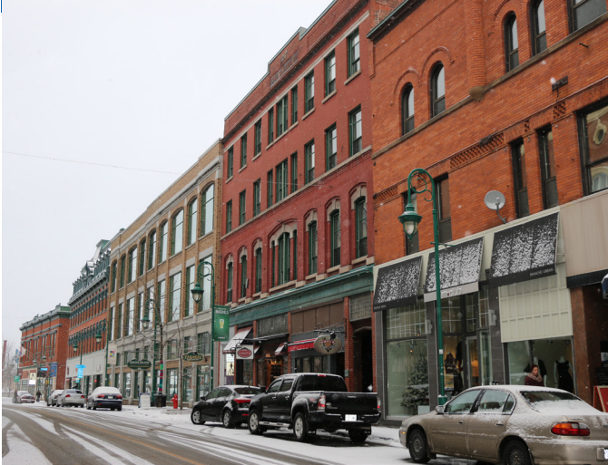
Figure 36 : Restauration des façades au centre-ville de Sherbrooke
