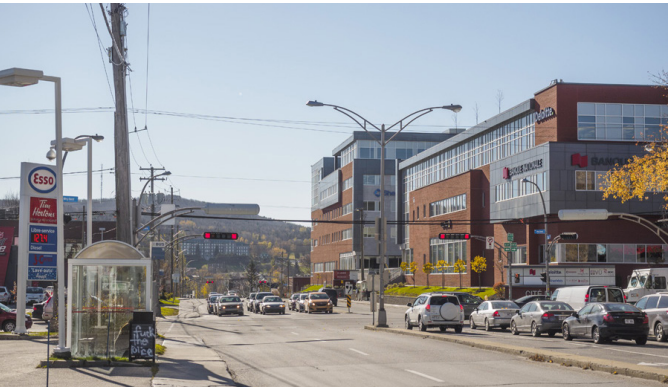
Figure 22 : Aménagements publics de la rue King Ouest à proximité du boulevard Jacques-Cartier
