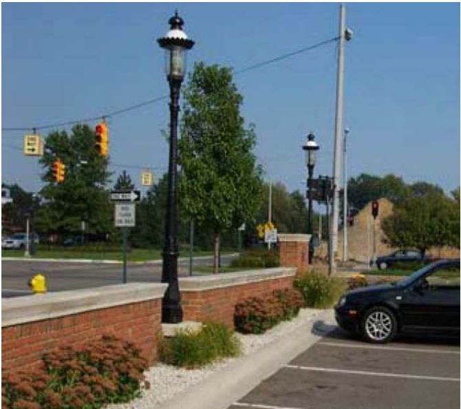
Figure 88 : Exemple de muret sur le terrain privé délimitant l'espace du stationnement hors rue
