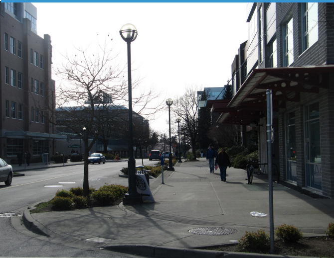
Figure 46 : Rétention des eaux de pluie au niveau des saillies
