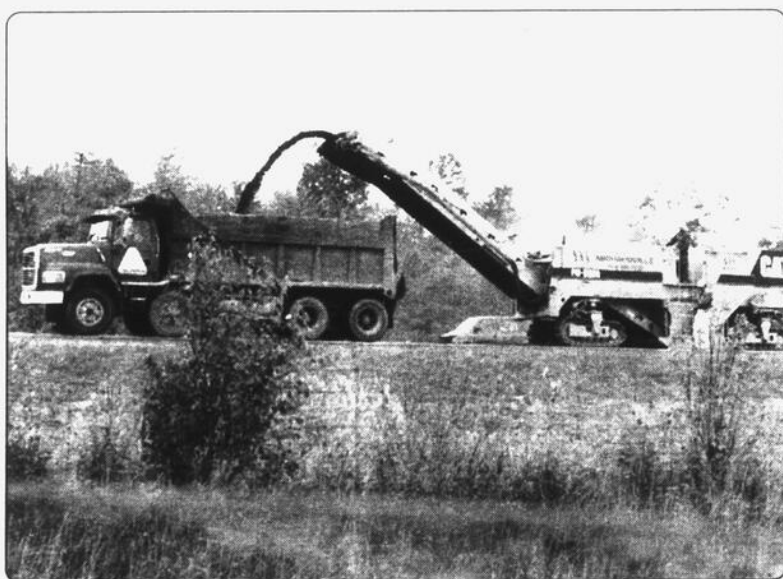
La deuxième phase du chantier de planage et de pavage de l'autoroute 35 est sous la direction de l'entrepreneur «P. Baillargeon Ltée».
