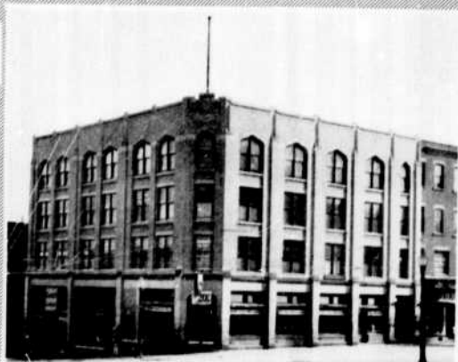
Edifice actuel érigé sur le site ci- dessus mentionné.
