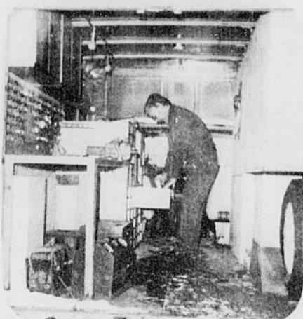
Cooke et Fils Enr. possède 2 unités mobiles équipées pour faire les réparations sur place.
