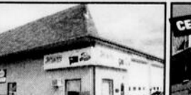
Garage de mécanique 40'x40' , situé à proximité du boul. Labbé, très bonne construction, 3 lifts, ce bâtiment peut aussi servir à d'autres vocations.
