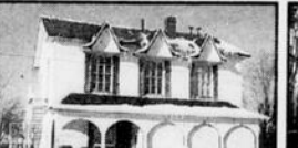
Sortie de ville , grande maison 2 étages, 10 pièces, thermopompe.
