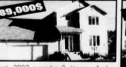
189,000$ Const. 2003 superbe 2 étages, 4 ch., belle cuisine avec armoires en chêne, escalier bois franc, beau salon avec foyer, grand garage double, beau terrain. www.mariolabarre.com
