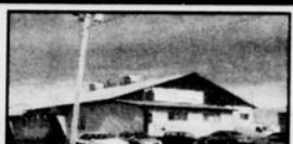
Bâtisse industrielle de 9300 p.c. avec quai de chargement, région de Victoriaville.
