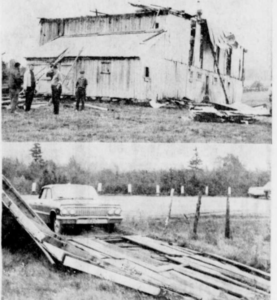
"TORNADE" A ROBERTSONVILLE. — L'orage qui a déferlé sur la région de l'amiante lundi soir a pris la force d'une véritable tornade dans le 6e rang de Robertsonville. Le plus touché fut M. Joseph Bisson, qui n'a vu son garage ainsi que la toiture de sa grange emportés par le vent, comme une feuille de ce qui reste du garage. L'automobile qui est à distance de quelque six arpents. La photo du haut montre les dégâts causés à la grange de M. Bisson, et celle du bas illustre papier. Les débris se sont échoués sur ce travail à l'intérieur de ce dernier n'a toutefois pas été endommagé.
