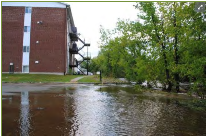
Photo 1 : Inondation suite aux fortes pluies, 2 septembre 2013
