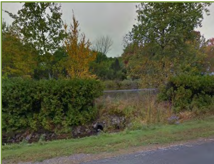
Photo 4 : Étang artificiel de rétention des eaux de ruissellement, avenue Corriveau, Magog
