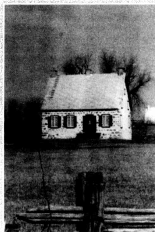
La maison Poitras, à L'Épiphanie classée monument historique, après sa restauration (960 Rang de L'Achigan Sud)
