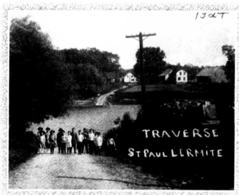
La traverse qui reliait Saint-Paul L'Ermite à Repentigny était située à environ 100m à l'ouest du pont Rivest.
