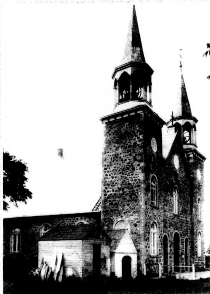
Construite en 1725, l'église de Repentigny est la plus ancienne du diocèse de Montréal.
