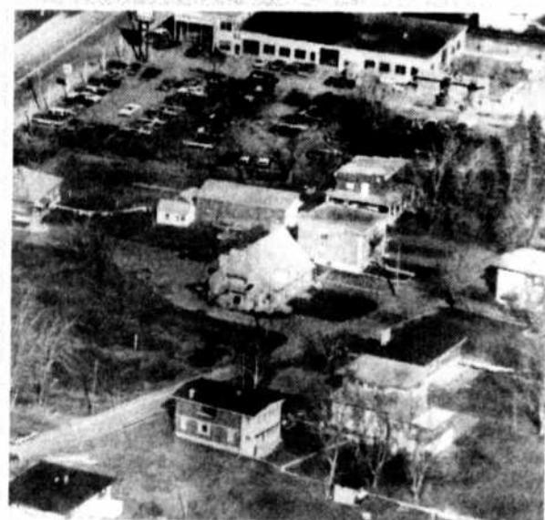
La maison Morisseau 18 e siècle au 595 rue Rivest, qui correspond à une portion du chemin du Roy originel. C'est le seul endroit où la rue Notre-Dame ne suit pas l'ancien tracé.
