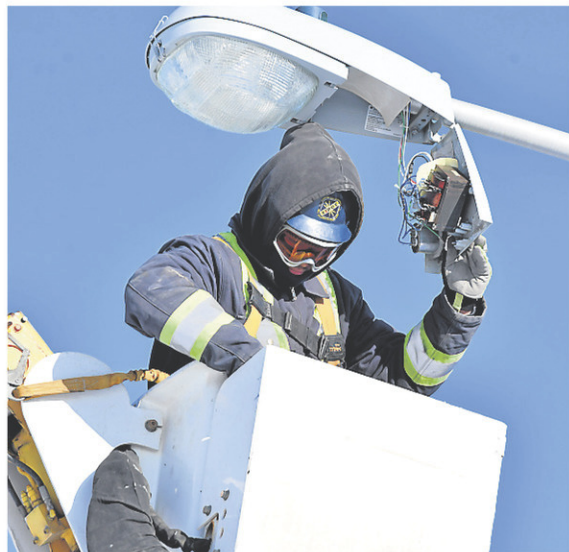
Des travailleurs spécialisés ont débuté le changement des luminaires dans les rues de Saguenay. — PHOTO LE QUOTIDIEN, ROCKET LAVOIE
