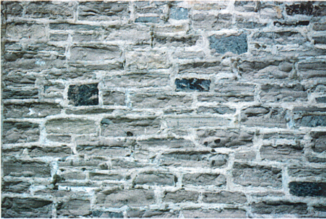
FIGURE 4 - Appareil assisé de calcaire du Groupe de Trenton provenant des carrières de Beauport. Maison à l'angle des rues Saint-Louis et Sainte-Ursule à Québec.
