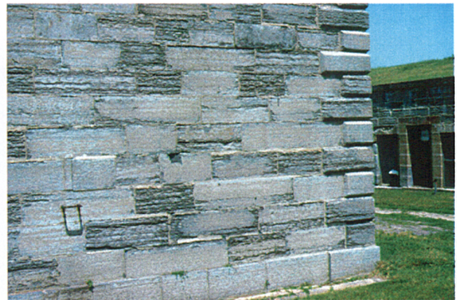
FIGURE 14 - Appareil à assises régulières de calcaire du Groupe de Chazy provenant des carrières de l'Isle Lamotte au Vermont; Fort-Lennox à l'Île-aux-Noix sur le Richelieu.
