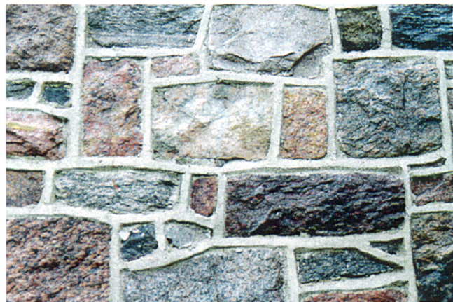
FIGURE 9 - Appareil typique de moellons de gneiss granitique du Précambrien que l'on peut voir sur de nombreuses résidences de Québec.
