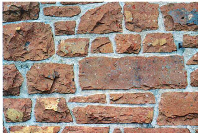
FIGURE 16 - Maçonnerie en brèche de l'île Sainte-Hélène.
