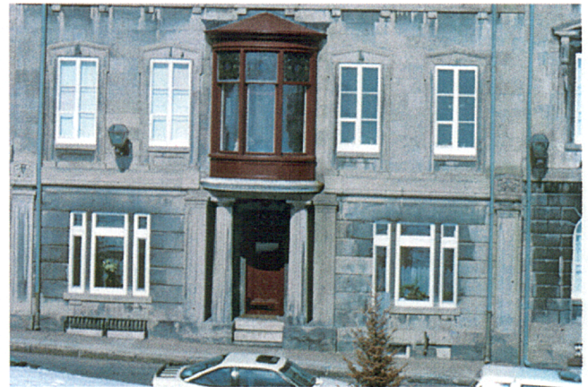
FIGURE 6 - Maison Hammond-Gowen sur l'avenue Saint-Denis à Québec, construite en calcaire de la Formation de Deschambault provenant des carrières de Pointe-aux-Trembles.
