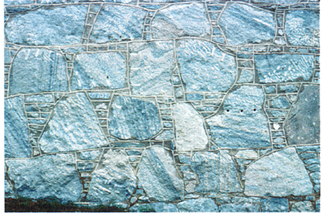
FIGURE 22 - Maçonnerie de moellons bruts en marbre rubané gris-bleu de Portage-du-Fort; église protestante dans le village de Portage-du-Fort.
