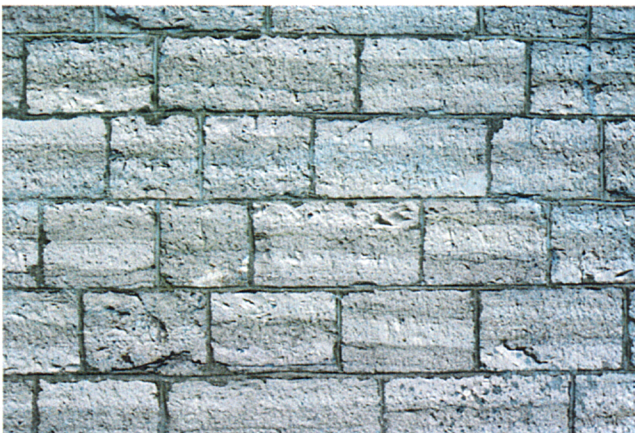
FIGURE 5 - Appareil réglé de calcaire du Groupe de Trenton provenant des carrières de Château-Richer. Façade de l'église de Château-Richer.
