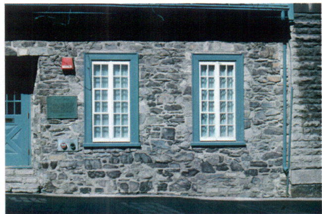
FIGURE 3 - Maçonnerie de Pierre noire du Cap sur la façade de la maison Cureux de la rue Saint-Louis à Québec.
