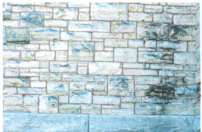
FIGURE 18 - Appareil assisé de grès du Groupe de Potsdam provenant d'une carrière de la région de Montebello; église de Montebello.
