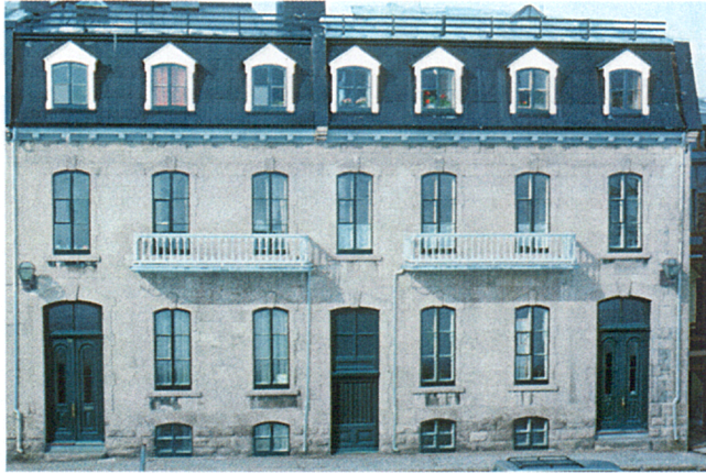
FIGURE 7 - Maison, sur l'avenue Saint-Denis à Québec, construite en calcaire de la Formation de Deschambault provenant de Saint-Marc-des-Carières.
