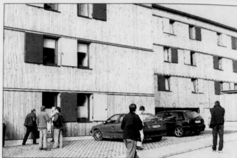
Les entrepreneurs ont pu visiter des bâtiments construits à partir de nouveaux produits du bois.
