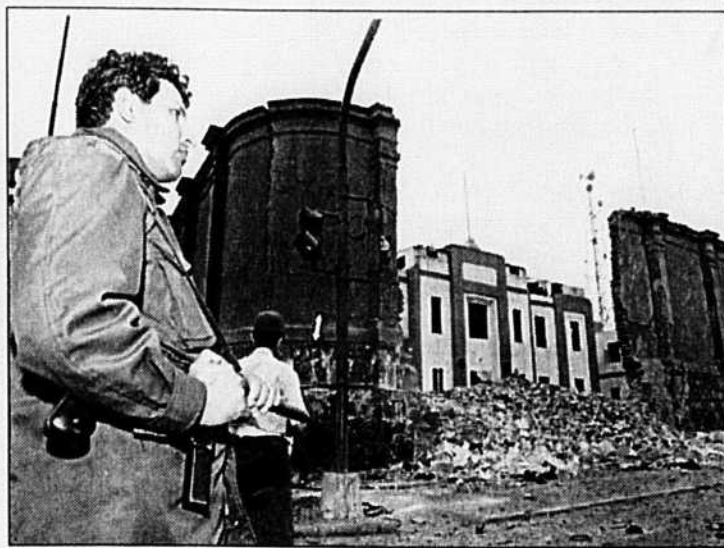
Deux voitures piégées ont gravement endommagé le quartier général de la police.
