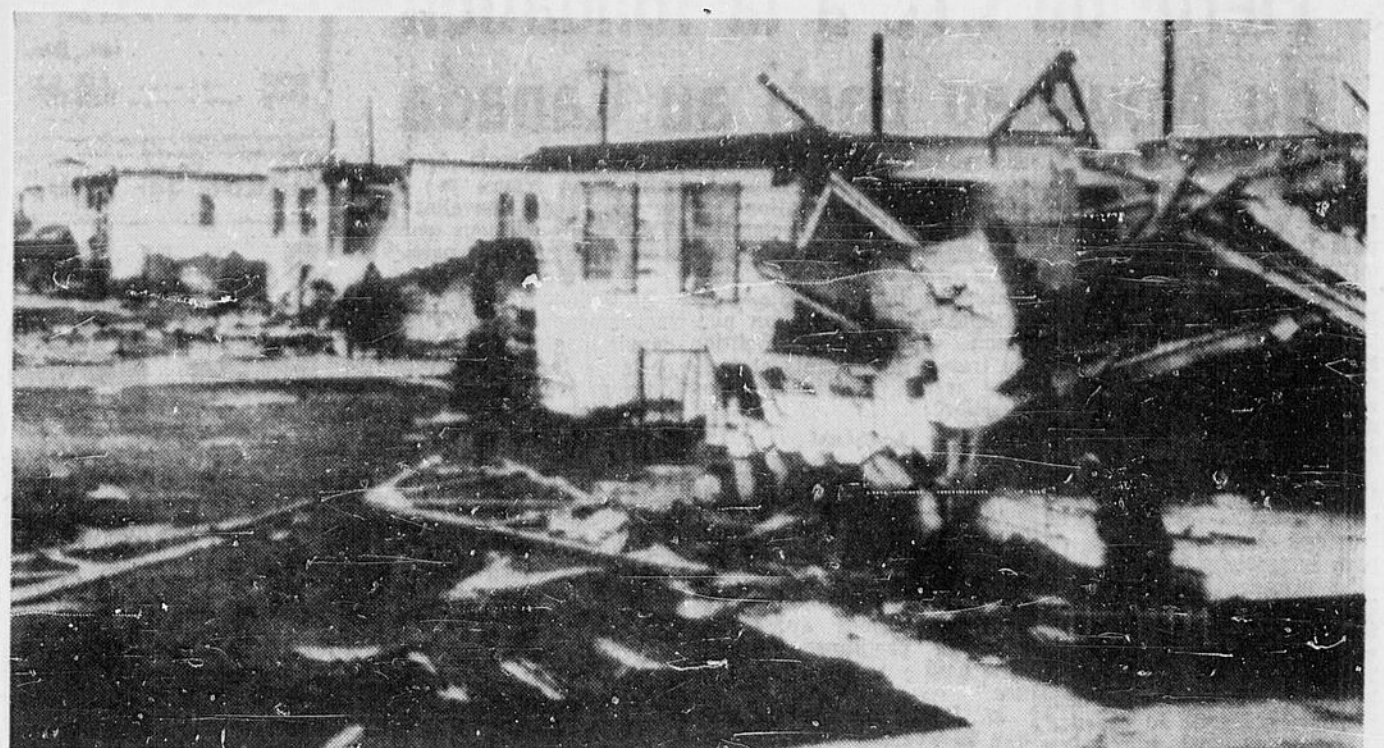
UNE TORNADE FAIT DES SIENNES — Cette photo nous donne une vue d'ensemble des huit maisons familiales, démolies récemment par une tornade, dans un nouveau projet
