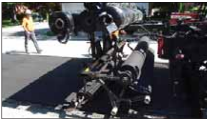
Mise en place de la membrane
