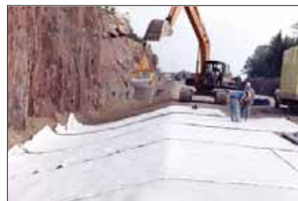
Figure 3 : Géocomposite bentonitique pour imperméabiliser un fossé
