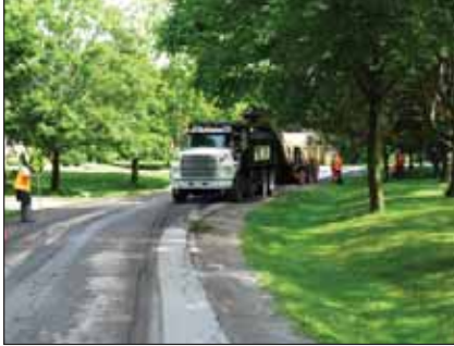
Préparation de surface de planage
