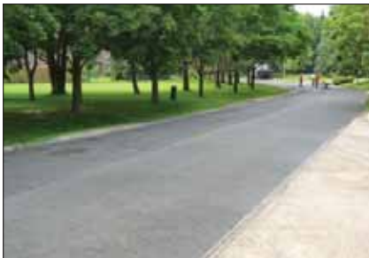
Membrane en place
