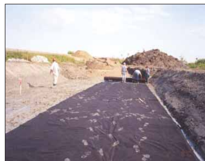
Figure 2 : Géotextile de séparation (type III) ou de renforcement (type II)
