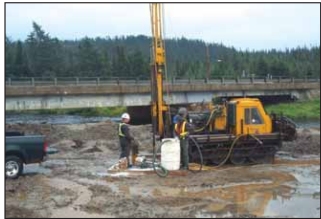
Figure 2 - Exemple d'une foreuse spécifique à la reconnaissance de sols
