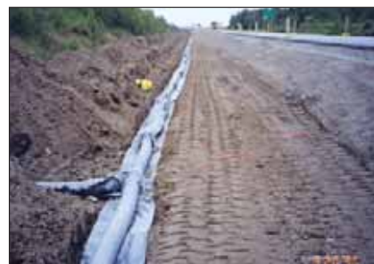
Figure 1 : Drain de rive enveloppé de géotextile filtrant (type IV)
