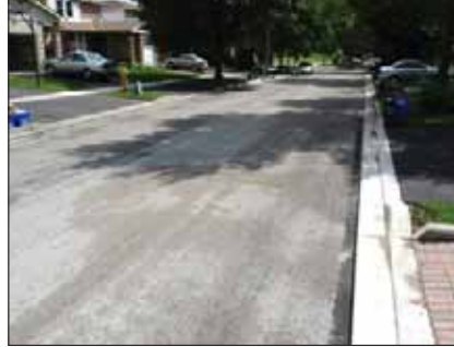
La surface est prête à recevoir la couche de surface
