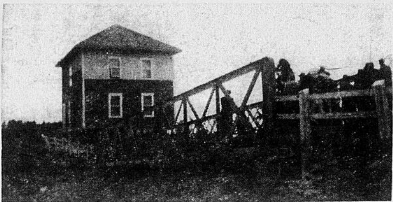
DEMENAGEMENT — On remarque sur cette photo la maison de M. Roland Bernard, de Saint-Victor, qu'on s'appête à faire traverser un petit pont. Les travaux de déménagement étaient confiés aux Lachance, de Saint-Evariste.
