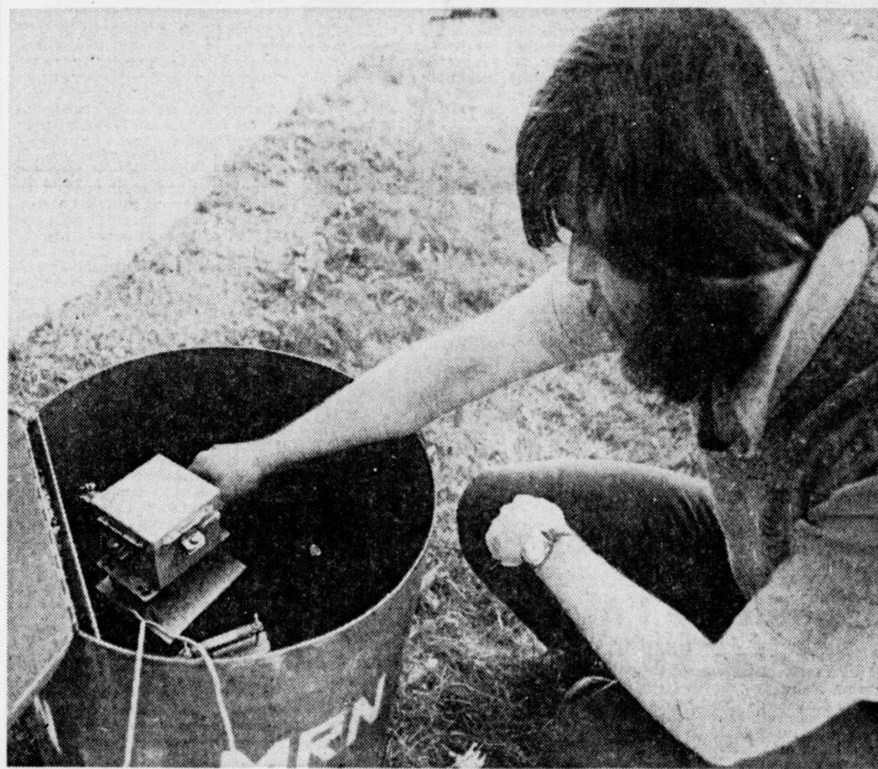
Les spécialistes du Service de géotechnique du ministère québécois des Richesses naturelles pensent à installer à Deschailions des systèmes d'alarme (comme celui que l'on voit ci-dessus) qu'un inclinomètre déclencherait dès que les terrains s'abaissent d'un seul degré.
