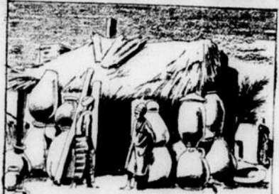
LES MAISONS de pozzes tunisiennes ont au moins un mur consistant en poterie de glaise.
