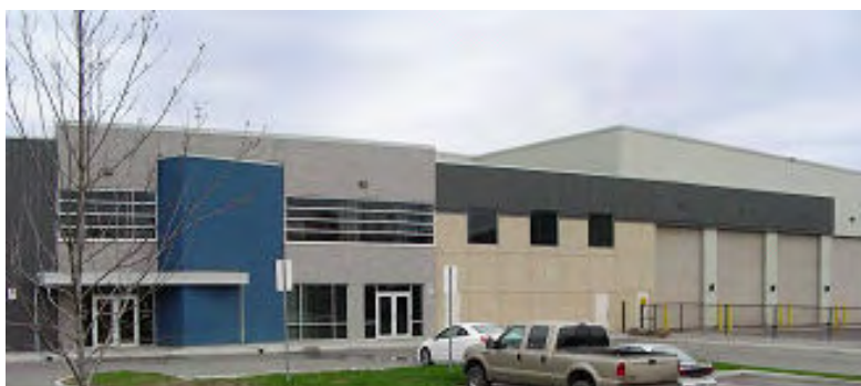
Figure 7-1-1 Centre de compostage centralisé de Hamilton, ON
