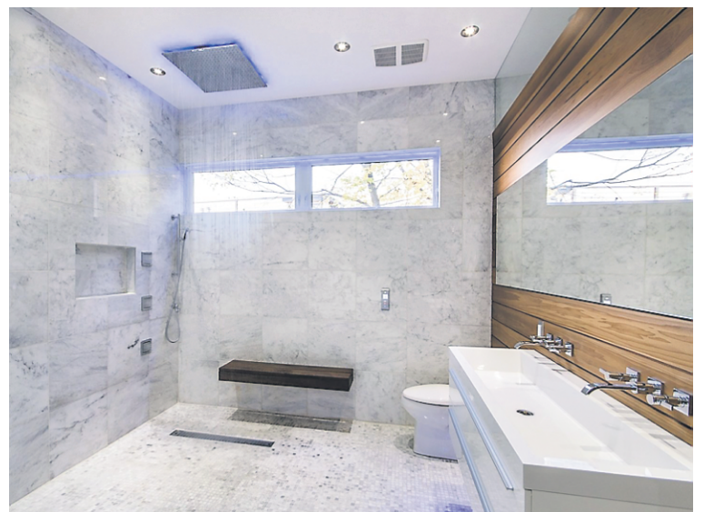
Ici encore, un mélange de matières froides et chaudes: le plancher en mosaïque est néanmoins chauffé. La douche est invisible: la pluie tombe du plafond et l'eau s'écoule grâce à une légère pente.
