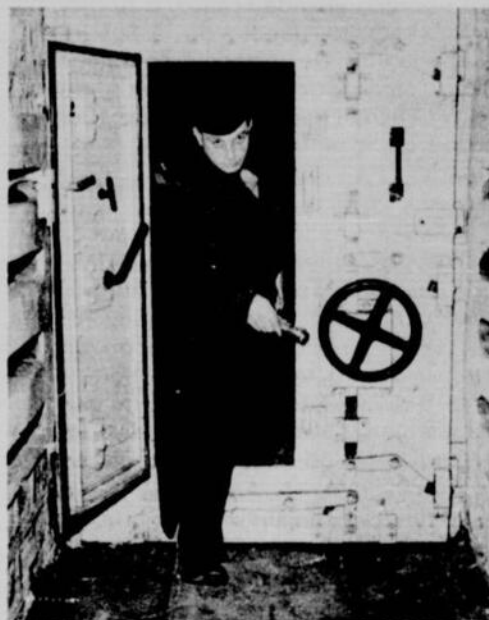
Chambre de surpression blindée pour purification de l'air après les combats, tir, etc. Cet ouvrage du Hackenberg, près de Thionville, peut contenir 1.200 soldats et 30 officiers (50 pour cent pour la défense et 50 p.c. pour les travaux d'entretien).
