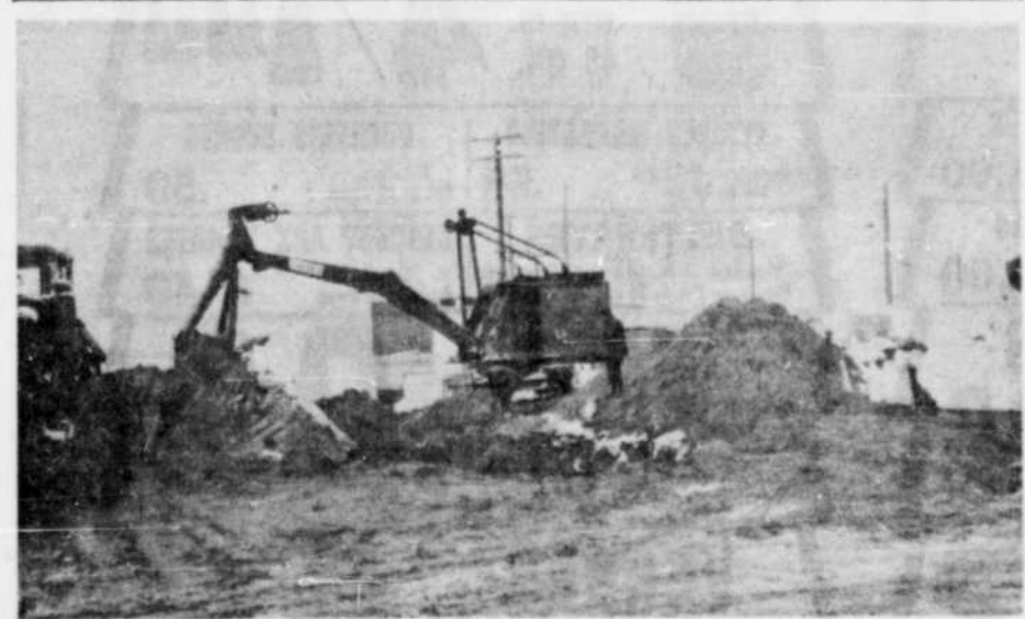
LA RUE du Filtre est temporairement fermée aux automobilistes étant donné que des employés sont à y changer le système dégâts et d'aqueduc qui se trouve dans la terre, en face de l'usine de filtration. Un contremaitre a expliqué
