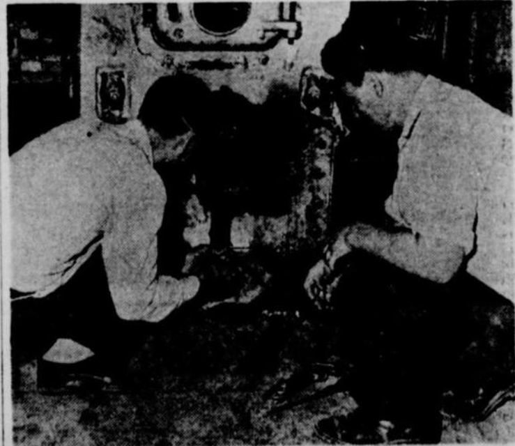
La fournaise de l'institution ayant besoin d'être examinée avant l'arrivée des grands froids, ROLAND X... prête un coup de main au R. F. NOEL (à gauche) qui démonte la souffluse électrique.
