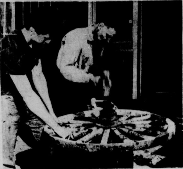
Vlan ! Un coup de masse bien appliqué a vite fait de replacer le moyeu.
