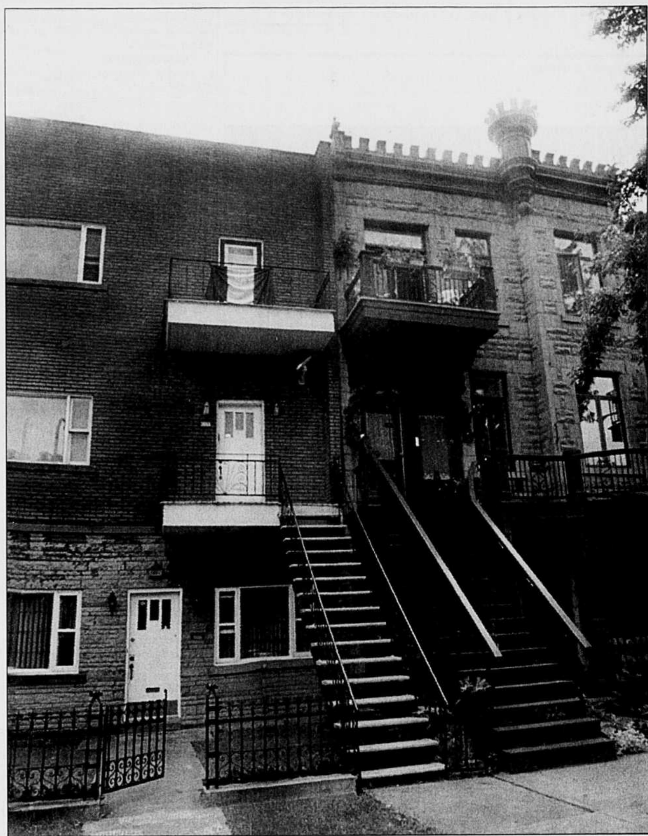
Deux immeubles restaurés avec des résultats bien différents, sur l'avenue du parc Lafontaine, sur le Plateau. La Ville de Montréal ne dispose que depuis 1994 d'un règlement d'urbanisme qui lui permet d'obliger les propriétaires à respecter les particularités de leur bâtiment.
