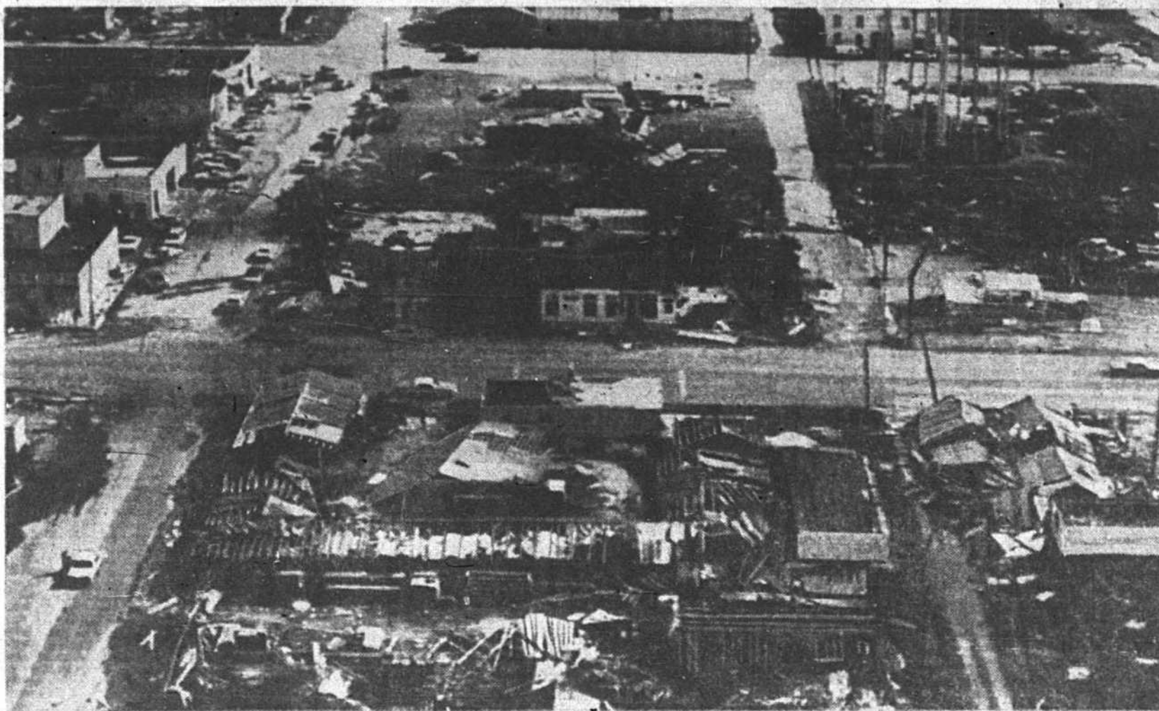
L'ouragan Celia sème la destruction à Aransas Pass. Des vents d'une vélocité de 145 milles à l'heure ont détruit des maisons et des édifices commerciaux dans le quartier où se trouve le réservoir
