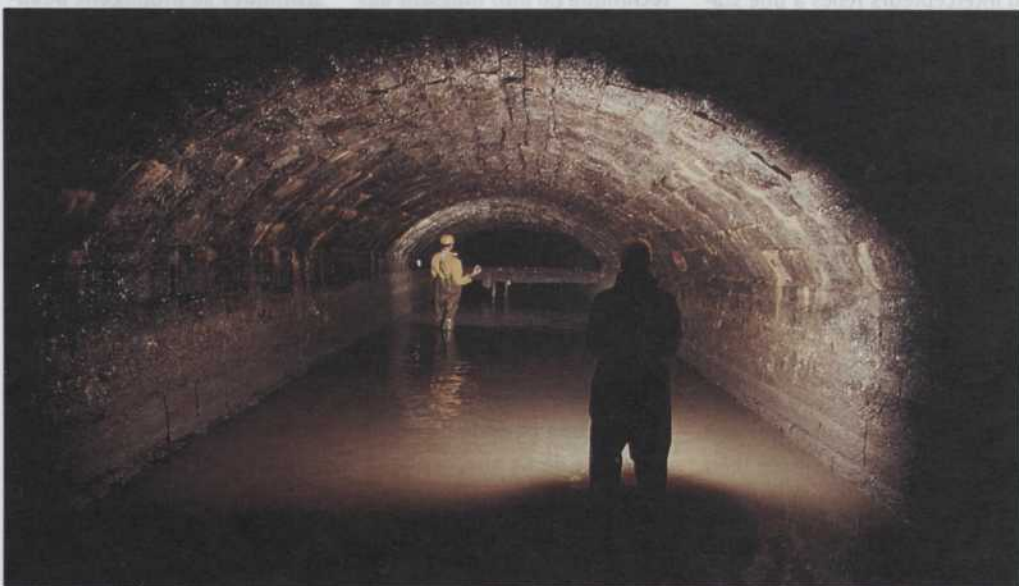
Égout collecteur de la rivière Saint-Pierre construit entre 1832 et 1838. Au moment du relevé archéologique effectué en 1939, cet égout était encore en usage, mais il est désaffecté depuis.
