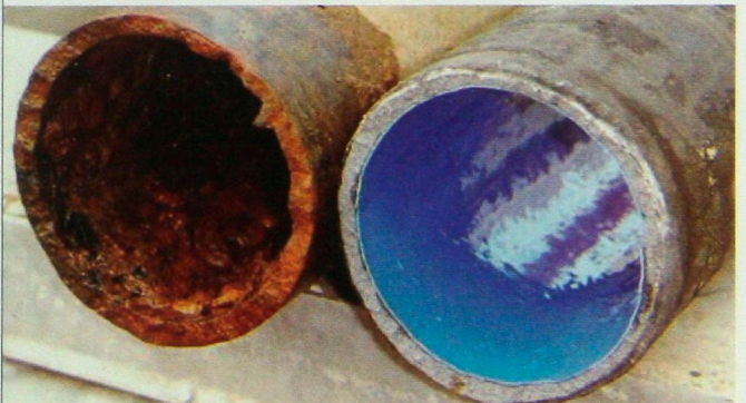
Conduite avant et après un traitement de projection d'époxy
