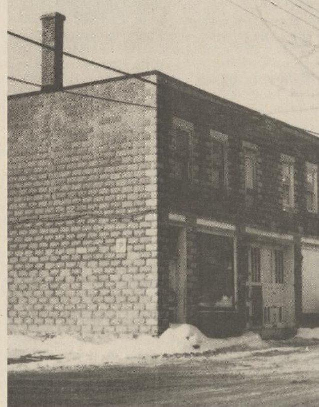
Voici le hangar où il a fallu creuser deux pieds de profondeur pour permettre aux niveleuses de pénétrer à l'intérieur pour se mettre à l'abri.
