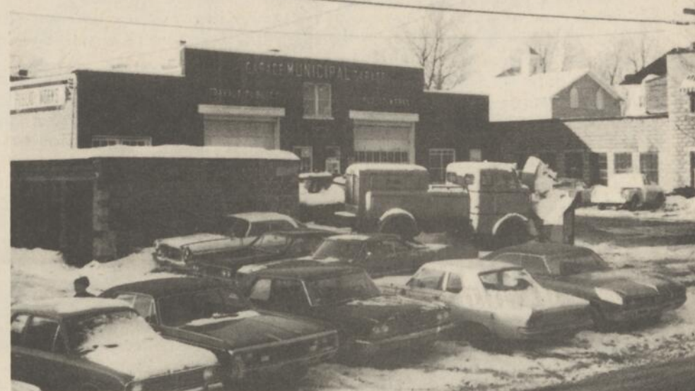
Une illustration de l'encombrement quotidien qui obstrue l'entrée du garage municipal et la souffluse que l'on doit déplacer soir et matin pour procéder à des réparations sur des pièces de l'équipement.
