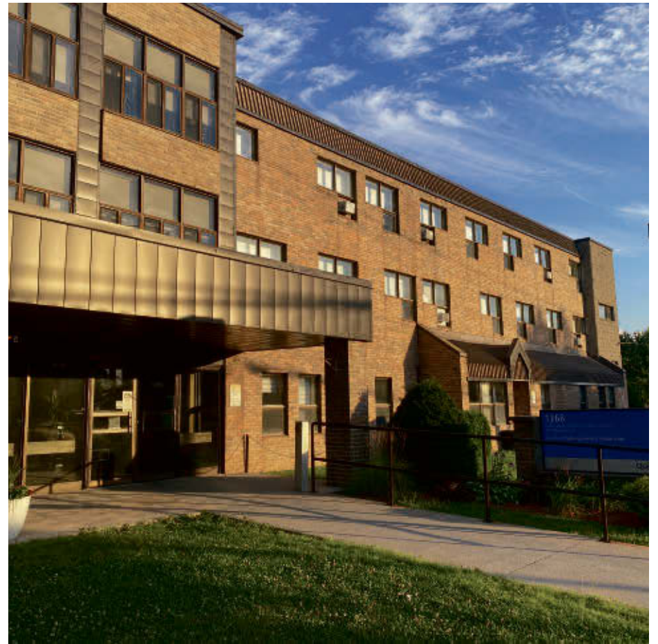
Le rez-de-chaussée du Centre d'hébergement de la MRC d'Acton est fermé aux usagers jusqu'à nouvel ordre. Photo Sarah Villemaire | La Pensée ©
