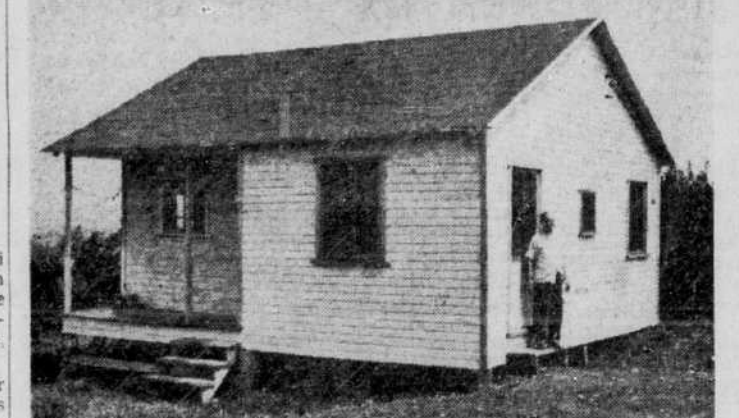
UN REVE REALISE; M. et Mme ARNOLD GILMAN, demeurant à 22 rue Walnut, Pawtucket, Rhode-Island, viennent de réaliser un projet qui caressaient depuis vingt ans. En effet, ils viennent de se construire à 2644 chemin Ste-Foy un petit chalet où ils viendront à l'avenir passer non seulement leurs vacances mais demeurer pendant plusieurs mois de l'année. M. et Mme Gilman sont venus à Québec pour la première fois, il y a déjà de nombreuses années. Ils se plurent tellement ici qu'ils y revinrent d'année en année et projettent de s'y établir un jour. Leur rêve est maintenant réaliste. (Photo du "Soleil")
