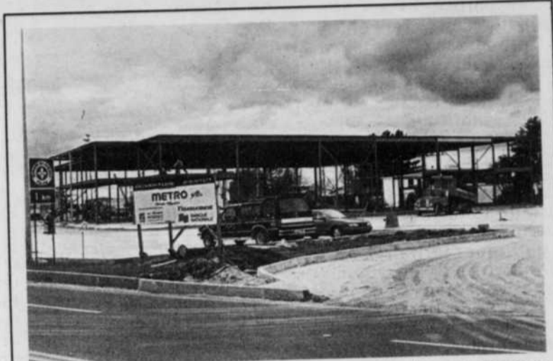
NOUVEAU- Comme on peut le constater, les travaux de construction du nouveau supermarché Métro progressent bien à l'entrée du secteur Dolbeau. Le nouveau magasin d'alimentation est d'une superficie de 25 000 pieds carrés.
