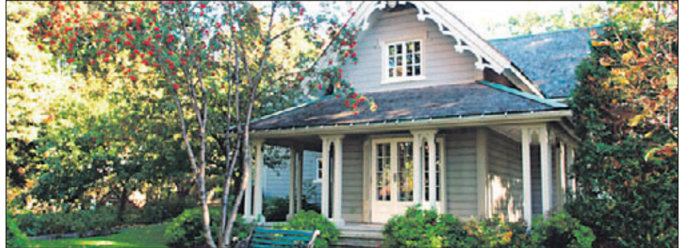
La Villa Bagatelle (chemin Saint-Louis, arrondissement de Sainte-Foy-Sillery-Cap-Rouge).
