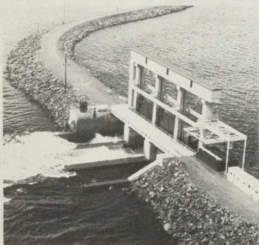
Un de nos projets... l'aménagement hydroélectrique de Churchill Falls
