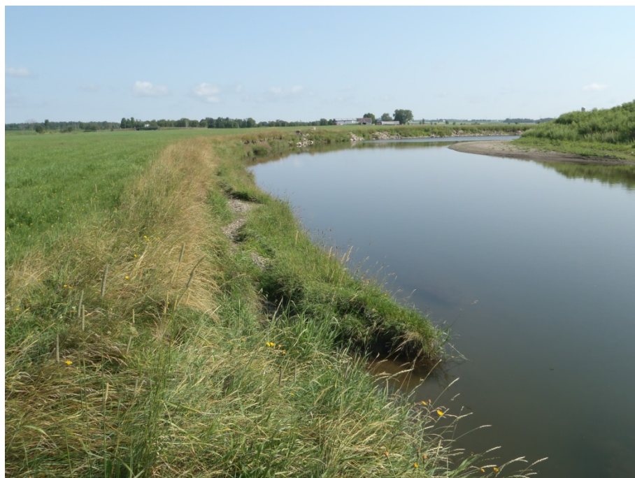
Photo 2 : Rive droite, PK 19,3. Autre exemple de rive de priorité 1. À l'arrière-plan, la rive concave est partiellement protégée avec de l'enrochement.
