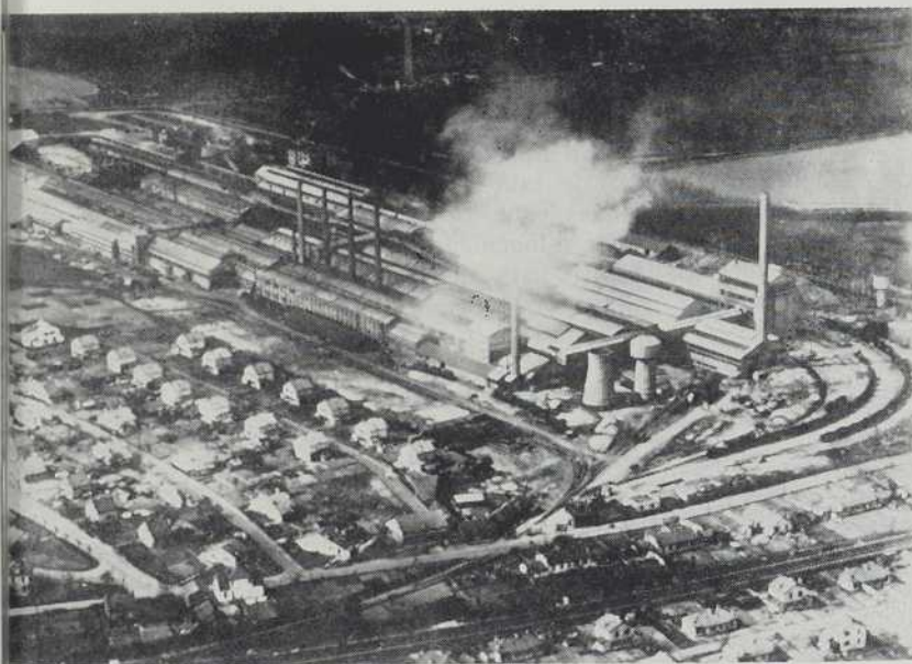
L'USINE DE CHANTEREINE (FRANCE). EN PLUS DE LA GLACERIE, ON APERÇOIT LES CITES OUVRIÈRES ET LES BASSINS DE DECANTATION A BOUE.
