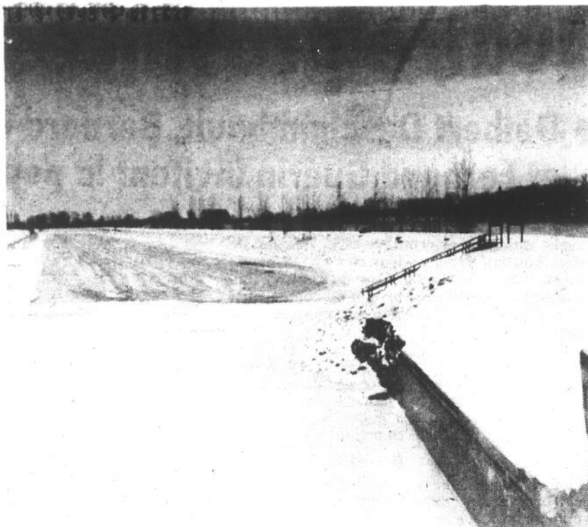
La glace de la bande du canal n'est pas encore assez épaisse pour supporter la grosse machinerie. Mais les cols bleus ont tout de même réussi à enlever la neige. (Photos Jacques PAUL)
