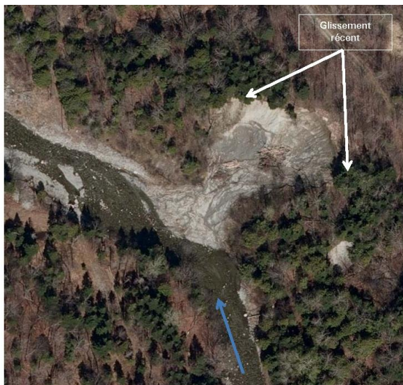
Vue aérienne de l'érosion
