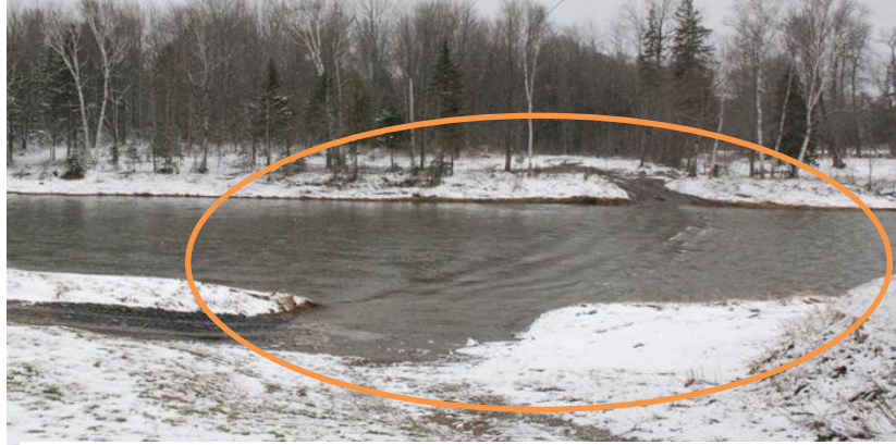
Figure 36: Résultat de l'érosion des ornières du chemin d'accès au passage à gué en milieu forestier
