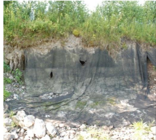
Figure 31: Érosion d'un enrochement
