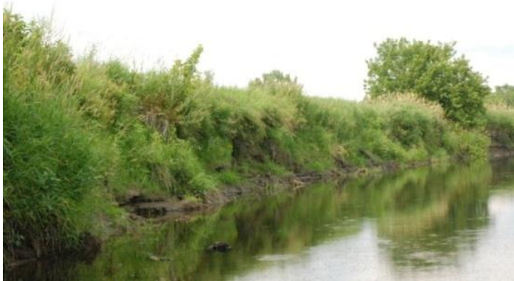
Figure 30: Zone de décrochement semi-végétalisée
