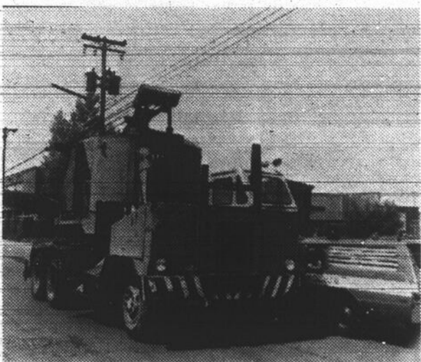
Cette grue mécanique a provoqué une panne d'électricité majeure, hier après-midi, dans le nord de la ville, après avoir arraché des fils à haute tension, angle Marmier et de Gaspé.
