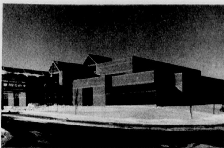
Avec l'implantation de l'Institut Maurice Lamontagne, l'est du Québec vient de se doter d'un centre de recherche en sciences de la mer de calibre international.
