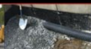
RÉPARATION DE DRAIN FRANÇAIS
