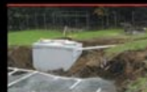
INSTALLATION DE FOSSE SEPTIQUE
