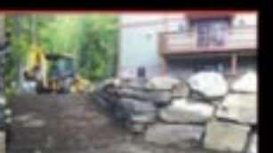
MUR DE PIERRE
